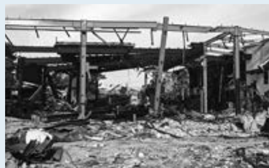
Η «Νεράιδα» κατεδαφίζεται
