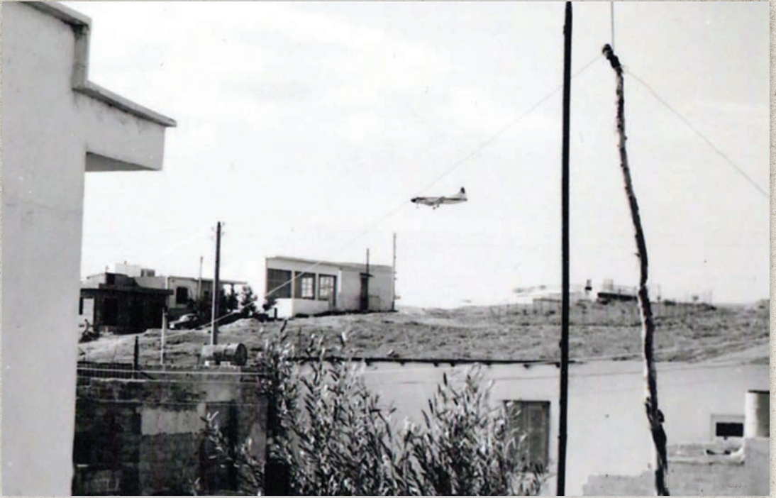
Περιοχή Αμπελακίων, οδός Υψηλάντου
