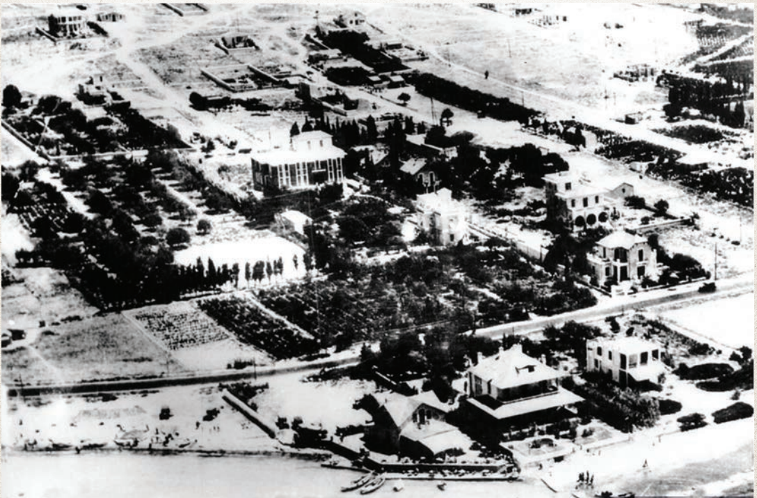
Αεροφωτογραφία κεντρικού Καλαμακίου (1938)
