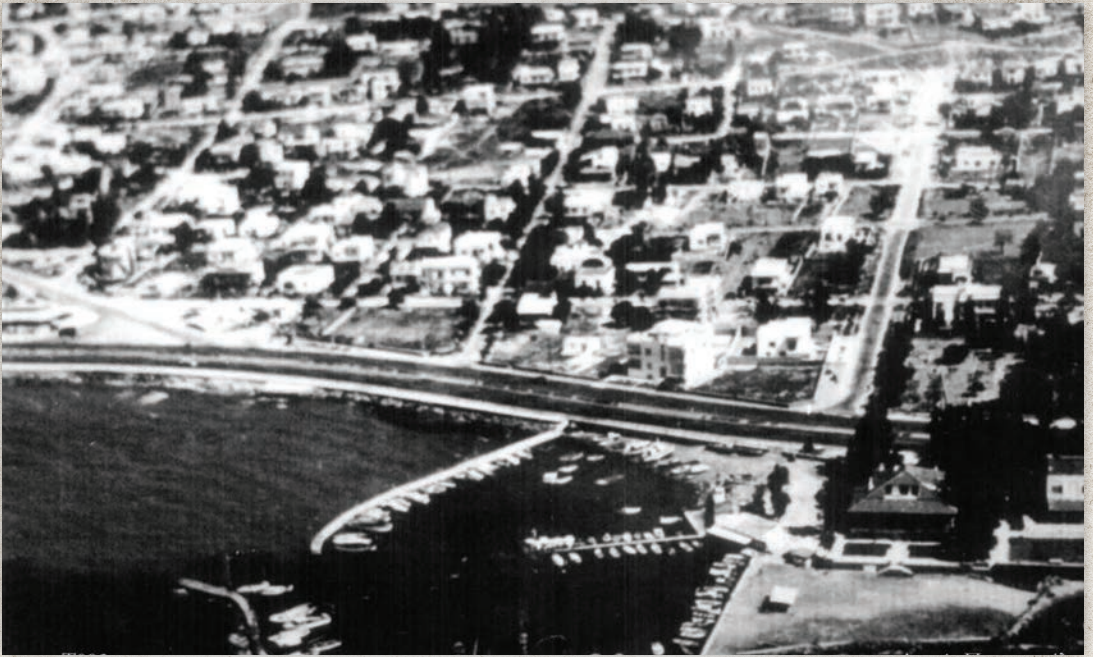
Άποψη κεντρικού Καλαμακίου (αεροφωτογραφία)
